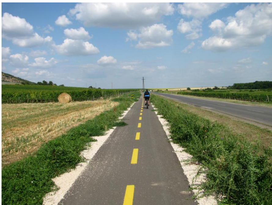
12. ábra: Közút melletti kétirányú kerékpárút Nagyharsány térségében.
