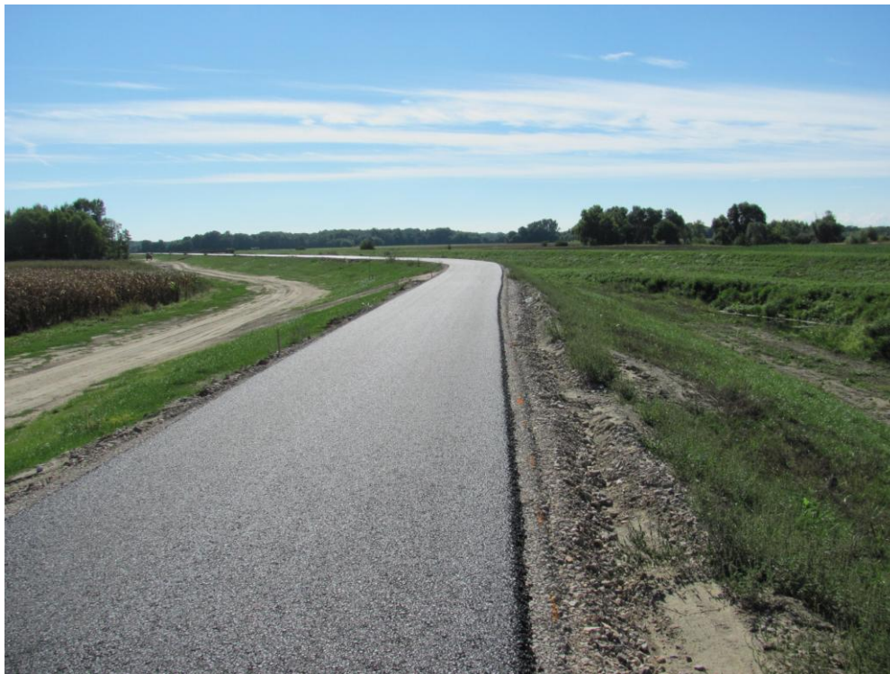
6. ábra: Az Ós-Dráva kerékpárút építés alatt.
