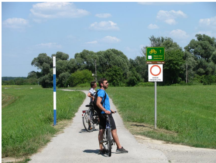
14. ábra: Aszfaltburkolattal ellátott árvízvédelmi töltés, mint kerékpárút Felsőszentmárton és Drávasztára között.
